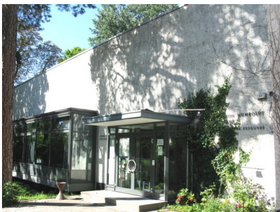
Alexander-von-Humboldt-Haus der Gesellschaft für Erdkunde, Arno-Holz-Straße 14, Steglitz
